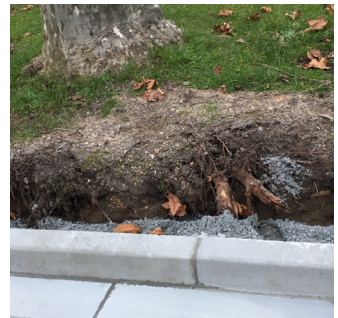
Racines sectionnées lors d'un chantier
